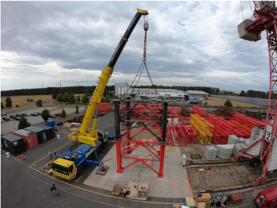
Ende Juni wurde das neue Turmelement erstmalig testweise auf dem Werksgelände in Luckau montiert. Mit einem Außenmaß von 6 x 6 Metern wiegt es 28 Tonnen. Für die Montage ist schweres Gerät nötig.
