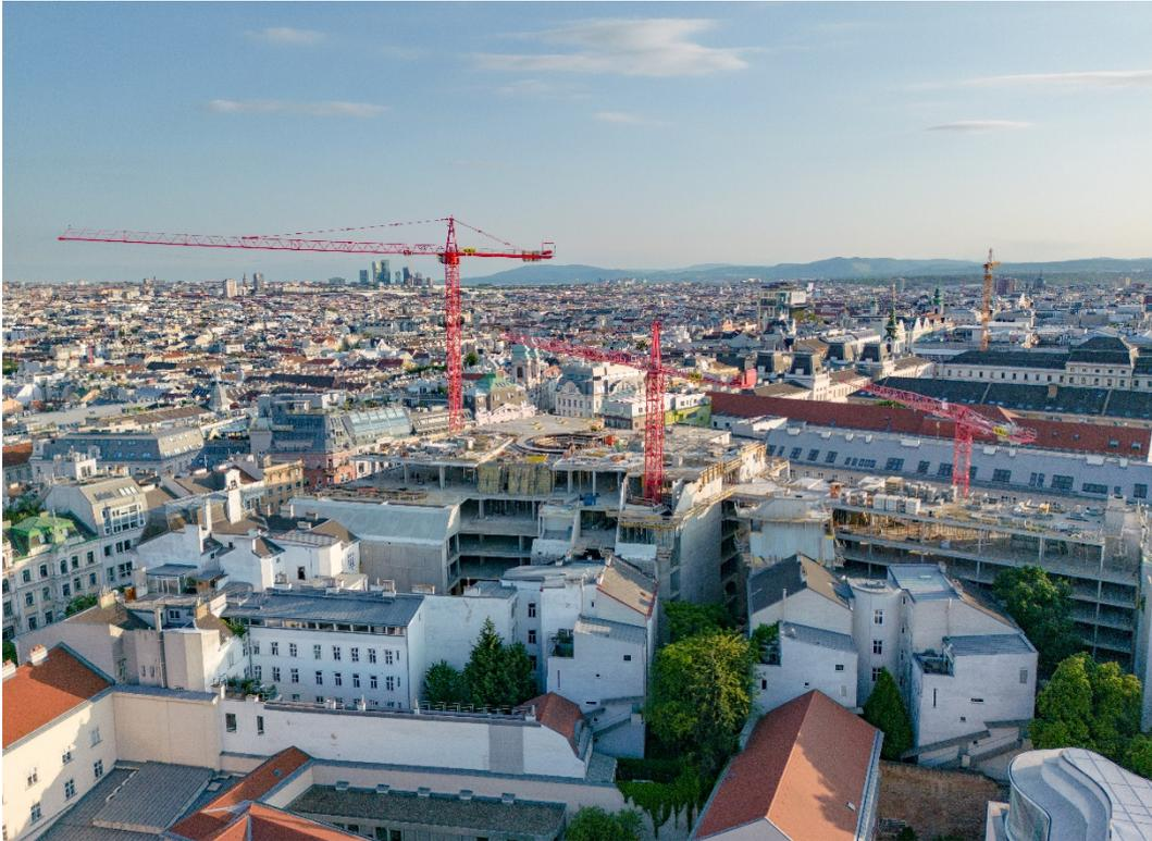
Sowohl der WOLFF 7532.16 als auch der WOLFF 6023.8 stehen aus Platzgründen mitten im Gebäude, weshalb sie nicht mit einem Autokran demontiert werden können. Der WOLFF 8033.16 wird den WOLFF 7532.16 demontieren, wozu der Gegenausleger des 7532.16 noch am Kran in zwei Teile zerlegt und aufwendig abgestützt werden muss.
